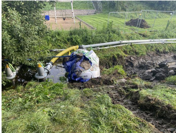
Figur 21 – Siteförhållanden, förberedelse av befintlig bäck för dräneringsrör
