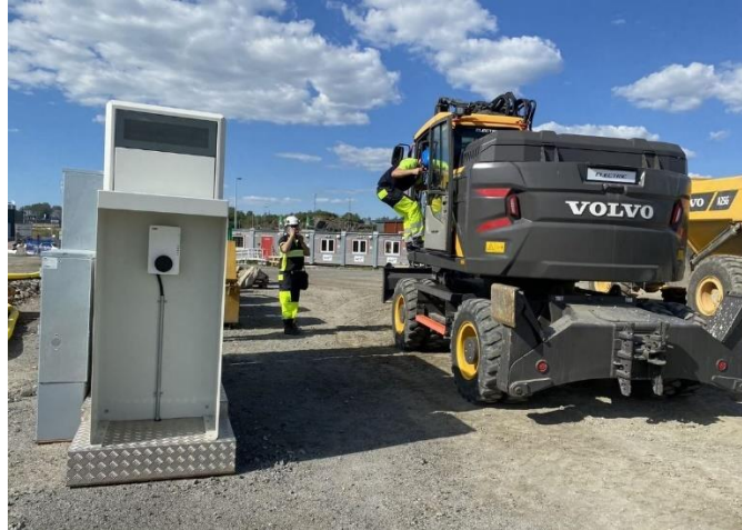
Figur 25 - Större batterielektrisk prototypjulkgrävare och laddningsutrustning, Albatross
