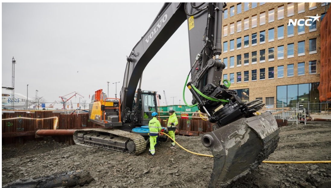
Bild 2 – 30-tonns kabelansluten bandgrävare på Habitat 7
