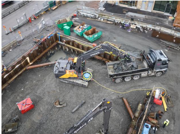
Figur 13 - Nätansluten 30tons grävare på Habitat 7
