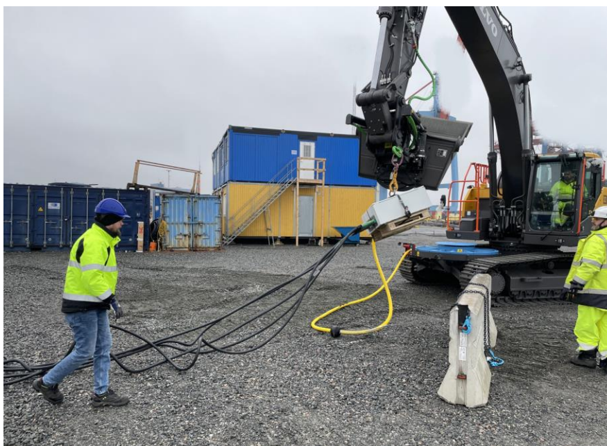
Figur 11 – Förflyttning av elektrisk infrastruktur, Göteborgs hamn
